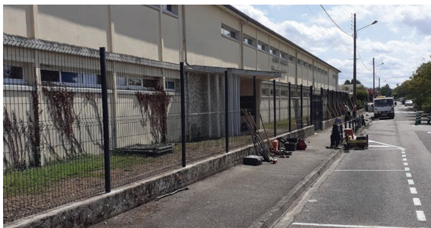
Groupe scolaire F. Buisson - Clôture rue Lavinal.
